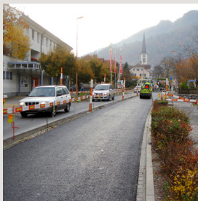
GESAMTSANIERUNG SARGANSER- STRASSE, BAD RAGAZ Baujahr 2011-2014 Bausumme Fr. 2.5 Mio.
