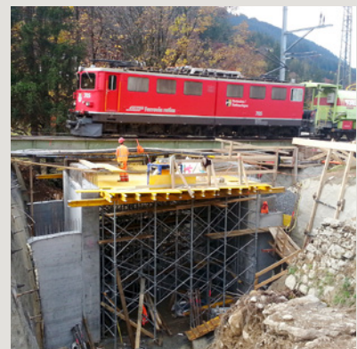
DOPPELSPURAUSSBAU RHB, KLOSTERS Baujahr 2013-2014 Bausumme Fr. 1.5 Mio.
