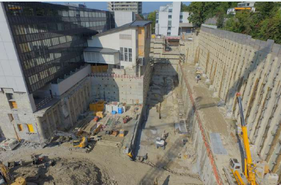
1 Baugrube ETH GLC Zürich
